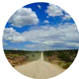
Schotterstraße (Ausfahrt 343 bis 346)
